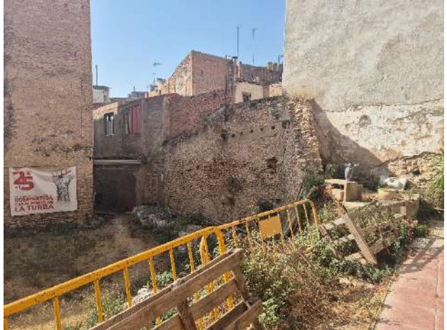
f2. vista cap al passatge de metges 16-18
