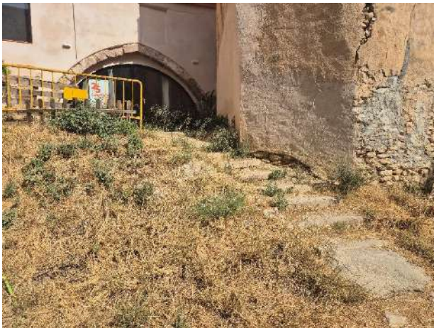
f3. vista del talus i el graonat provisional
