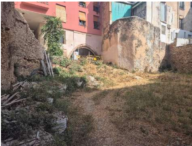
f5. vista del pati des de la cota inferior
