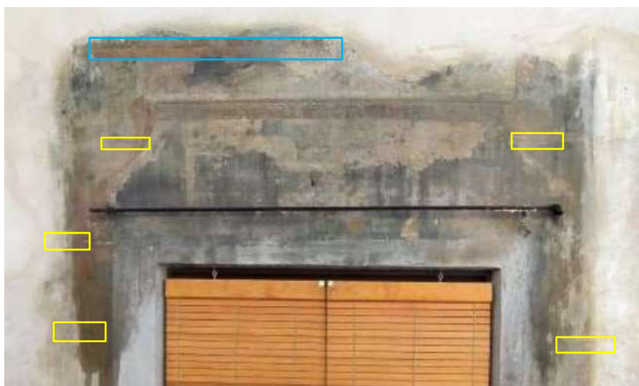
Fig.27.. Cala corresponent a la llinda de l'obertura central del primer pis un cop acabada. S'identifica la línia groga gruixuda superior, amb al línia vermella per sobre. També es pot veure la imitació d'una cornisa amb ombrejat i les línies vermelles del marc, així com també les que delimiten l'alçada dels carreus. Alhora es distingeix el cromatisme dels carreus, que va des del rosa fins a l'ocre.
