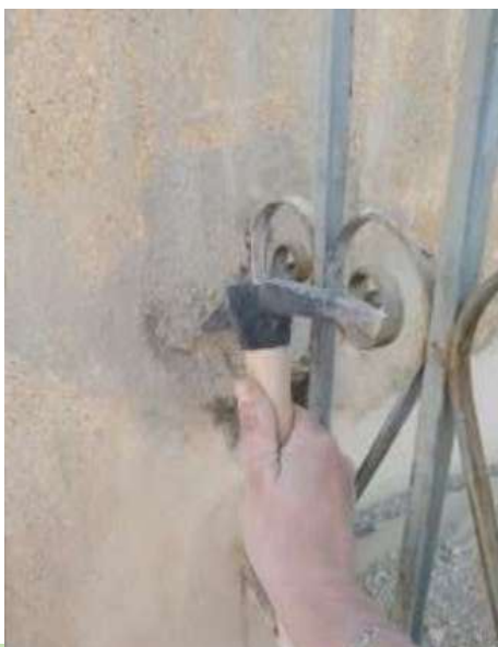
Fig. 36. Eliminació de morters impropis amb l'ajuda d'un pic
