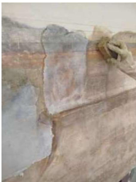
Fig.50. Última esbandida amb aigua desionitzada i esponja
