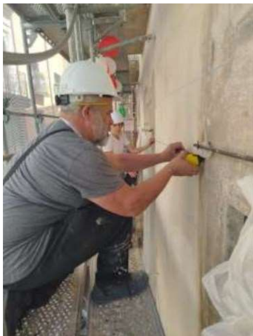
Fig.57. Traç de les primeres línies horitzontals amb la linyola.
