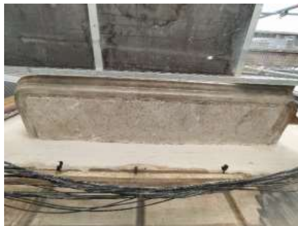
Fig.70. Retoc cromàtic pràcticament acabat.
