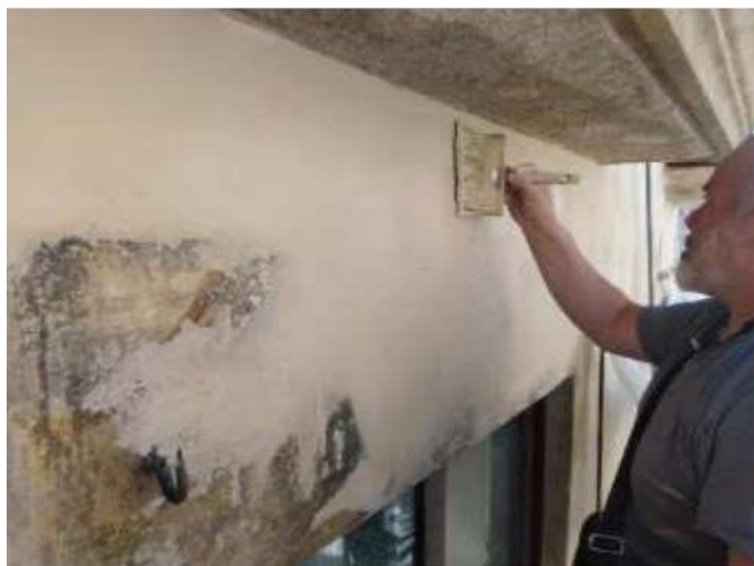
Fig.57. Aplicació del llevat de calç amb paletina.
