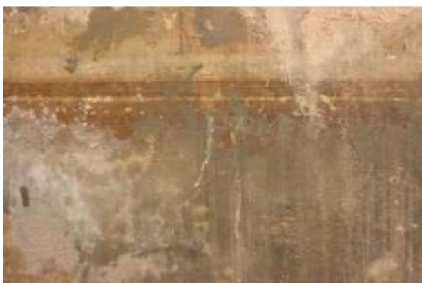
Fig.19. Capa de pintura gris que cobreix les decoracions originals
