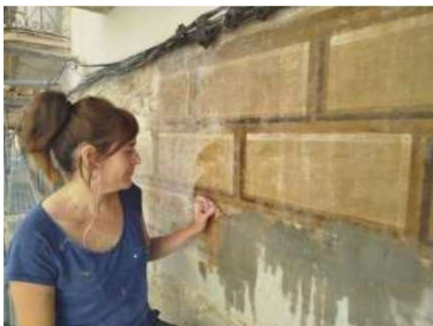
Fig.47. Eliminació de la capa grisa de la planta baixa
