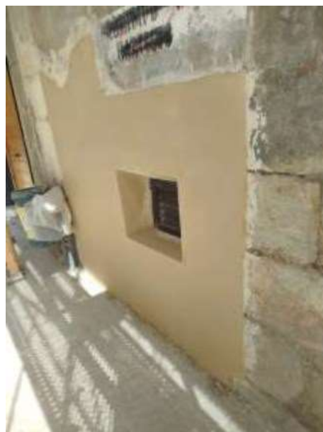
Fig.45. Aplicació de morter d'acabat
