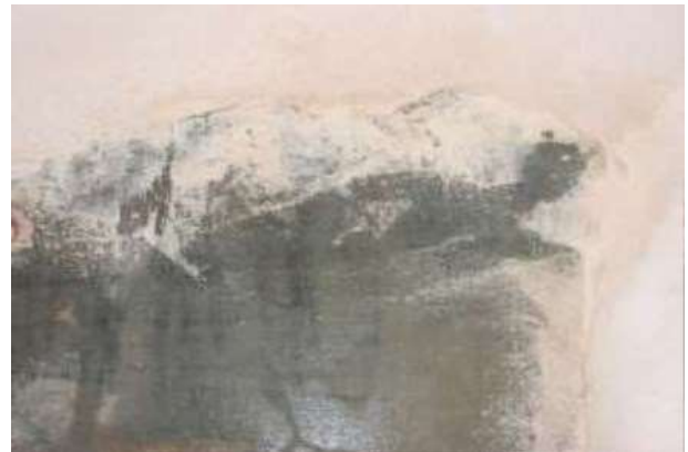
Fig. 5. Morters de reparació aplicats per sobre l'original
