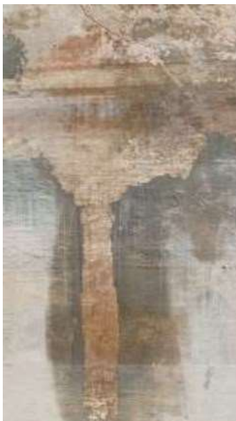
Fig.24. Primera cala efectuada sobre la llinda de l'obertura central del primer pis
