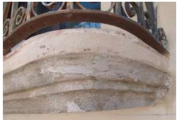
Fig.69. Reintegració matèrica de fissures i esquerdes.
