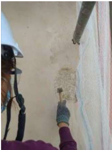
Fig.34. Repicat de morters impropis
