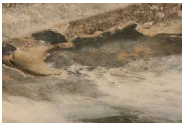
Fig. 15. Crosta negra localitzada en els sotabalcó
