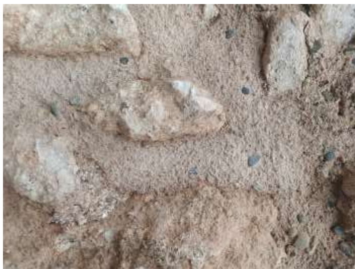
Detall del morter aplicat on s'aprecia la granulometria de l'àrid
