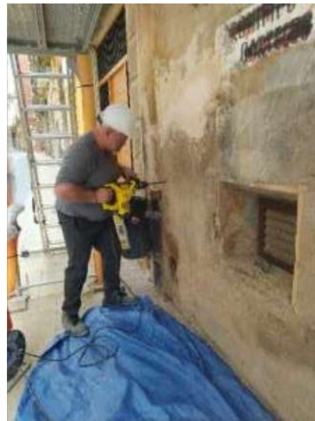
Fig 35. Retirada de morters impropis amb martell pneumàtic
