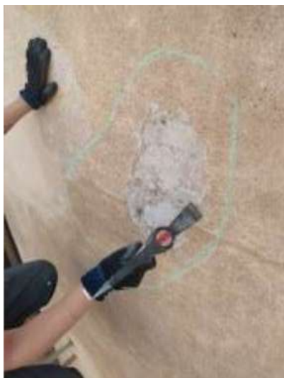
Fig.38. Repicat de bossa d'aire prèviament marcada amb guix.
