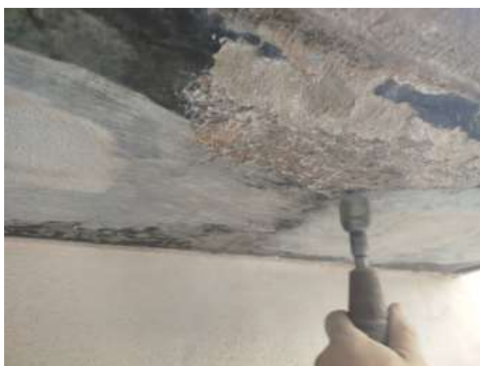
Fig.66. Acció del cisell pneumàtic sobre la crosta negra.
