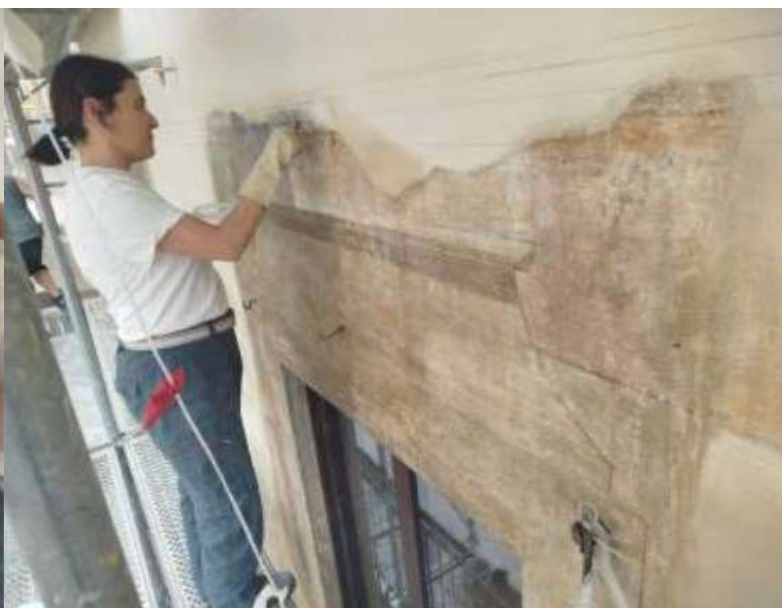
Fig.49. Retirada del gel amb espàtula
