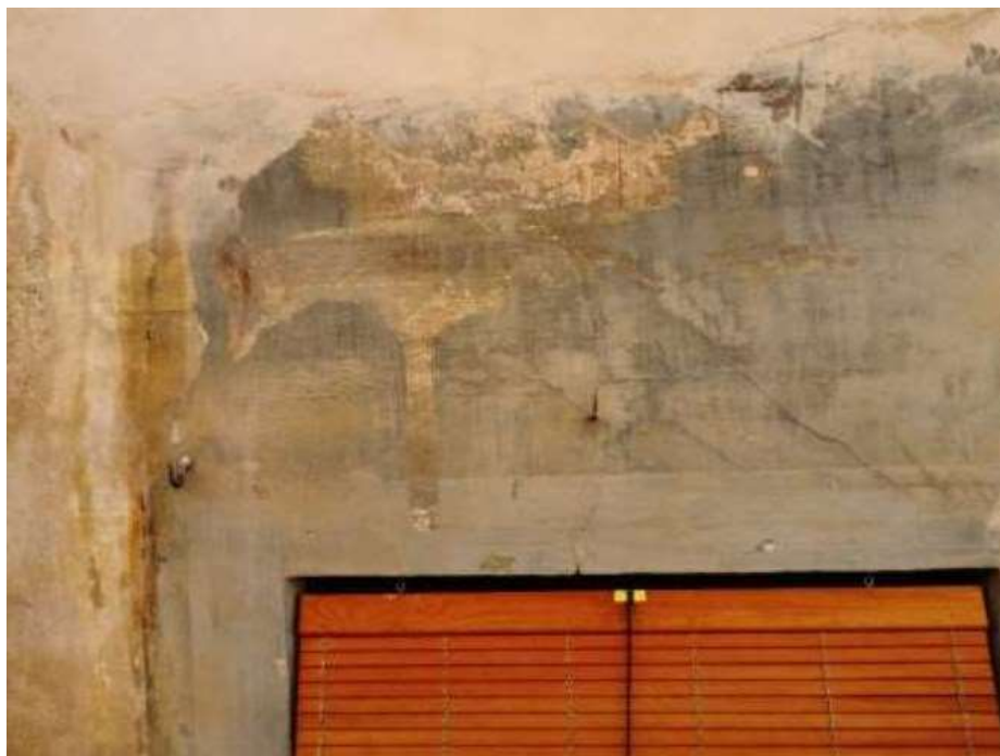
Fig.28. Cala efectuada a l'obertura dreta de la primera planta, Es poden distingir les formes del marc i la cornisa, així com el carreuat sobre d'aquesta.
