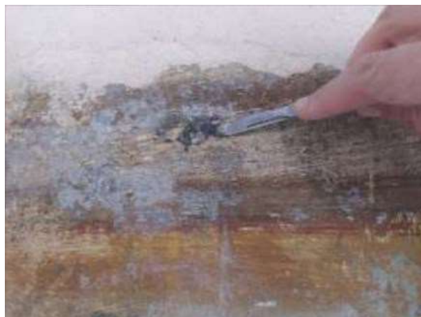
Fig.47. Eliminació de la capa grisa als pisos superior
