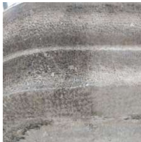
Fig.66. Meitat abans de raspallar per eliminar els residus després del tractament i meitat ja raspallada
