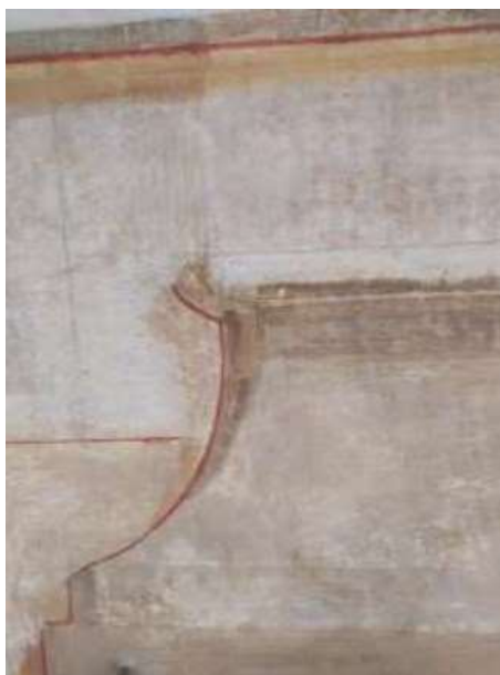
Fig. 56. sistema cromàtic original emprat per descriure els volums: l'ocre/blanc trencat per als plans emergents més exposats a la llum; el marró per a l'intradós o pla de transició, que defineix la profunditat del relleu; el vermell per a la línia d'arrencament del volum sobre el pla de mur; i el groc per a la projecció de l'ombra generada pel volum
