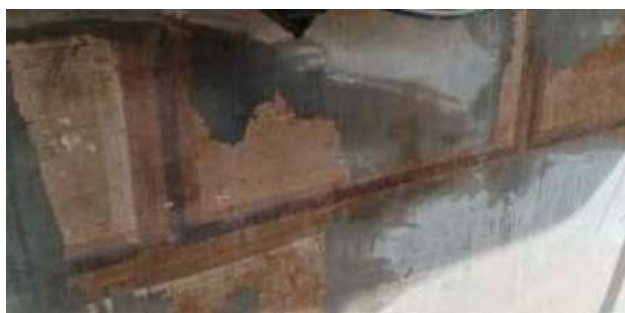
Fig. 23. Carreuat descobert a partir de la cala.
