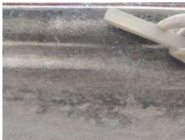
Fig.43. Raspallat per l'eliminació dels residus
