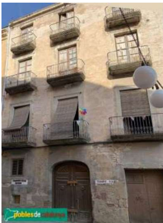
Fig. 1. Estat de la façana abans i després de la intervenció de 2023.. Es pot observar el desplaçament dels balcons i, en un to més clar, els morters de reparació aplicats durant el 2.023.
