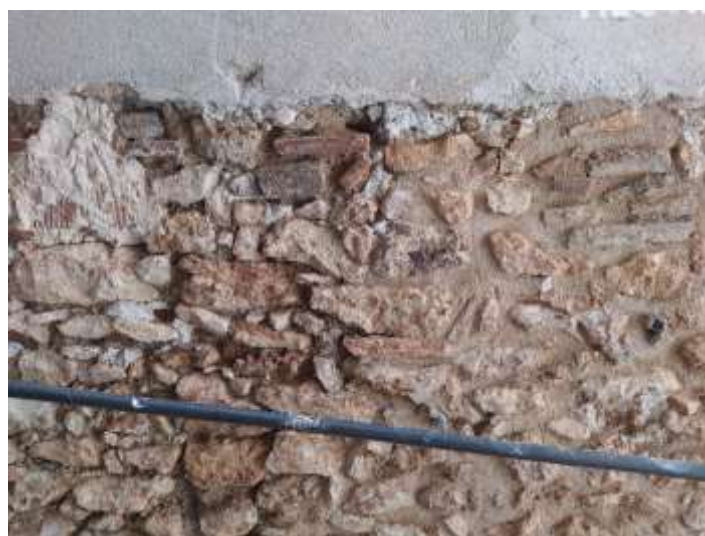
Fragment del mur oposat a l'arc amb la meitat dreta rejunxada
