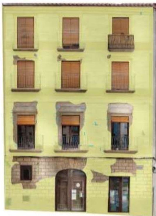
PLÀNOL 4: ACCIONS PRÈVIES A LA REPRODUCCIÓ DEL PROGRAMA DECORATIU. NETEJA DE LES RESTES ORIGINALS, LOCALITZACIÓ D'EVIDÈNCIES I HOMOGENITZACIÓ DE LA SUPERFÍCIE
