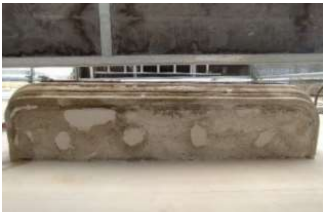
Fig.68. Reintegració matèrica dels orificis
