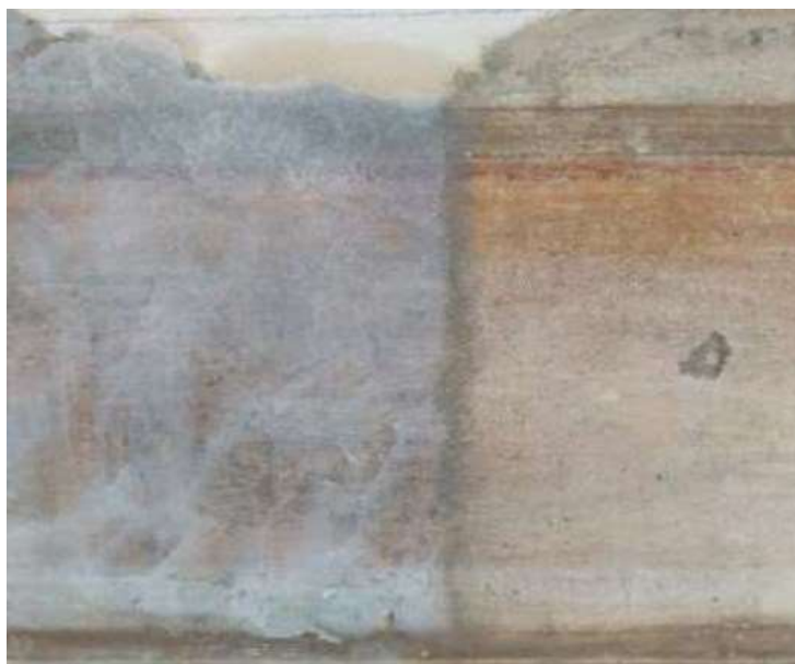
Fig.51. Imatge on es pot veure el gel aplicat al costat d'un tram ja netejat
