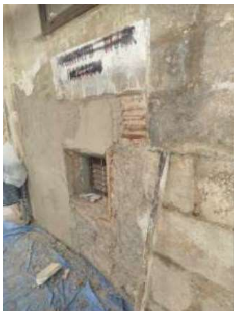
Fig.44. Aplicació de morter de base gruixut
