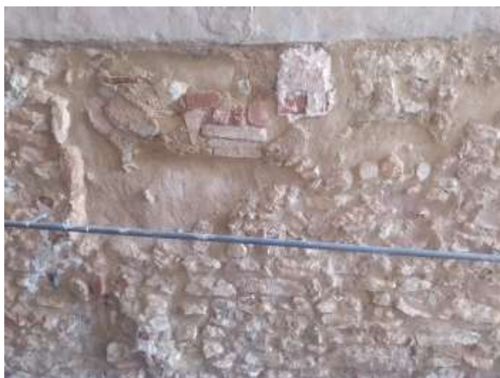
Tram del mur oposat a l'arc totalment rejuntat
