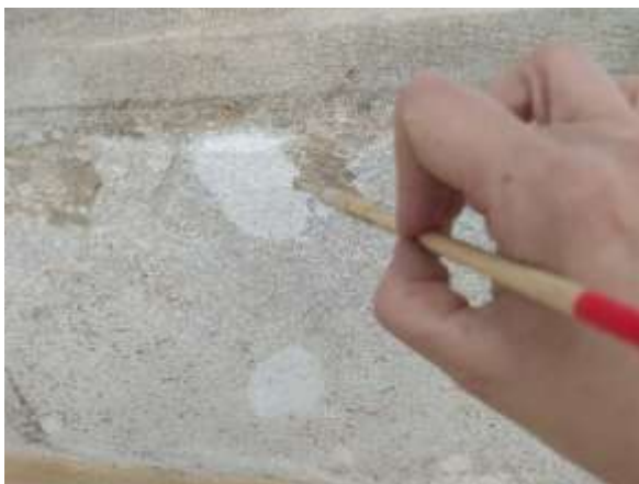
Fig.70. Retoc cromàtic dels morters de reintegració.
