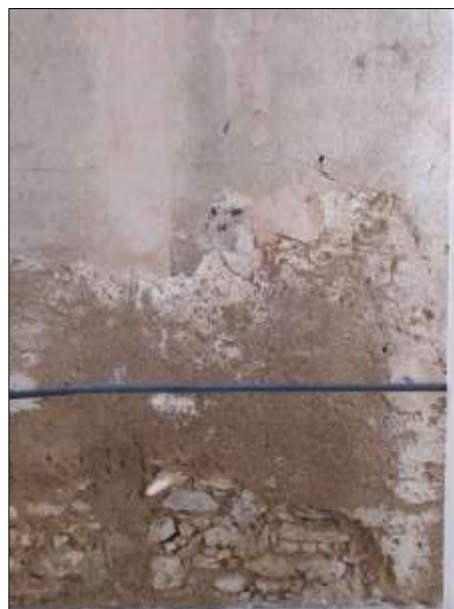
Reparacions en revestiment i pèrdua d'aquest a la art baixa
