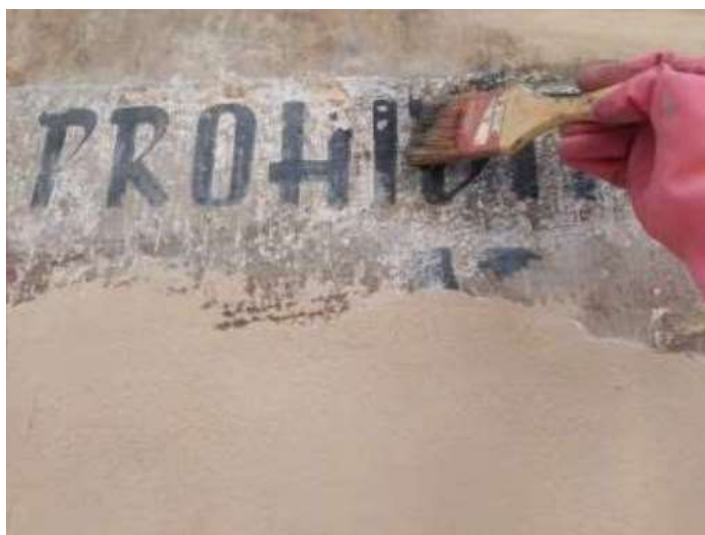
Fig.33. Aplicació del roducte decapant.
