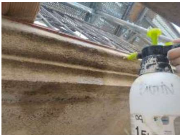
Fig.42. Aplicació del biocida amb nebulitzador.
