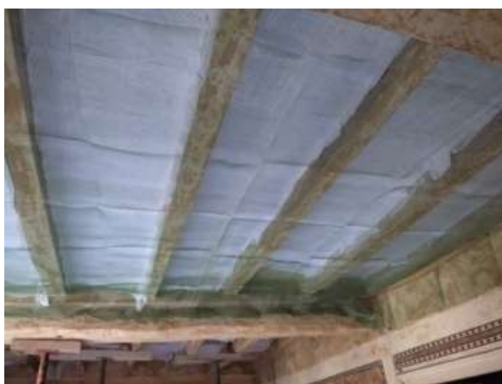
Fig. 8. Guixos engasats i amb la malla de protecció col·locada.
