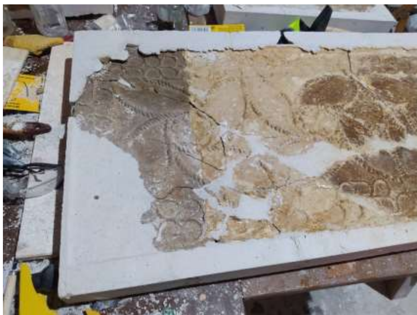
Fig. 35. Cantonada inferior desestucada i anivellada. Esquerdes i fissures centrals estucades. Zona superior pendent de desestucar.
