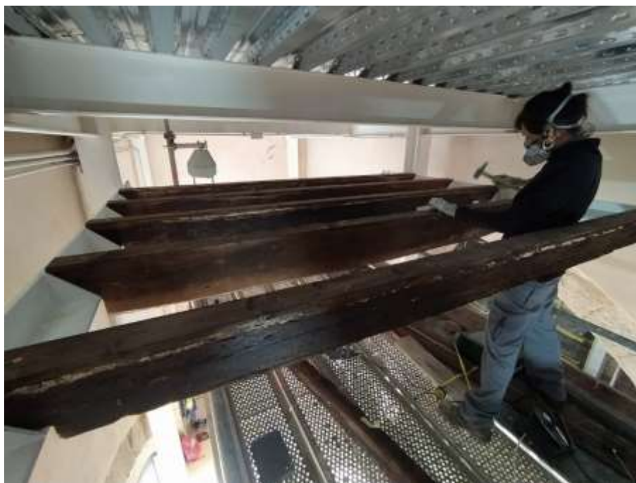
Fig. 48. Tractament de bigues i llistons amb Xylamon® Fondo Plus , un cop col·locades al nou emplaçament.
