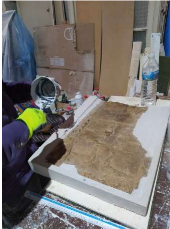
Fig. 36. Estucat de fissura (reintegració de guix).
