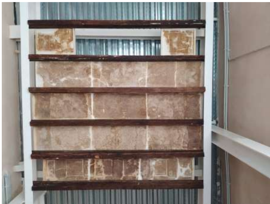
Fig. 53. Plafons un cop recol·locats i reintegrats matèricament.
