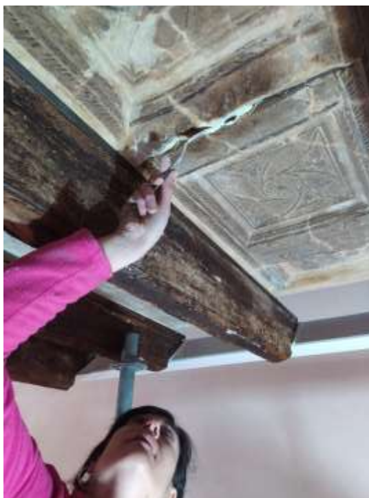
Fig. 52. Reblert d'espais entre seccions.
