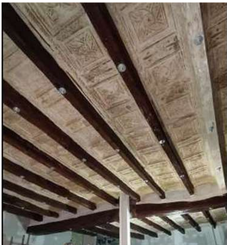
Vista general de la techumbre
