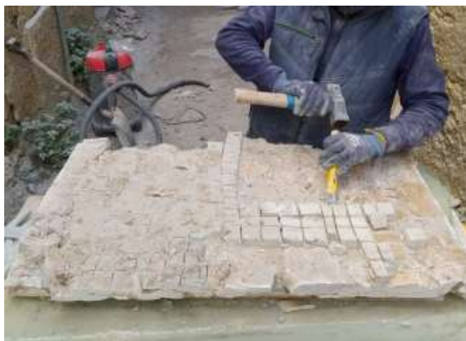
Fig. 26. Eliminació dels cubs de morter de guix amb escarpa i martell.
