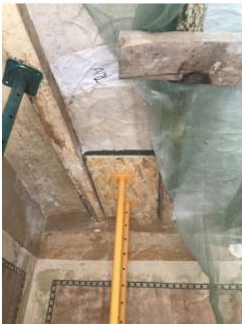
Fig. 15. Col·locació del plafó d'OCB i els puntals per la part de sota de la secció
