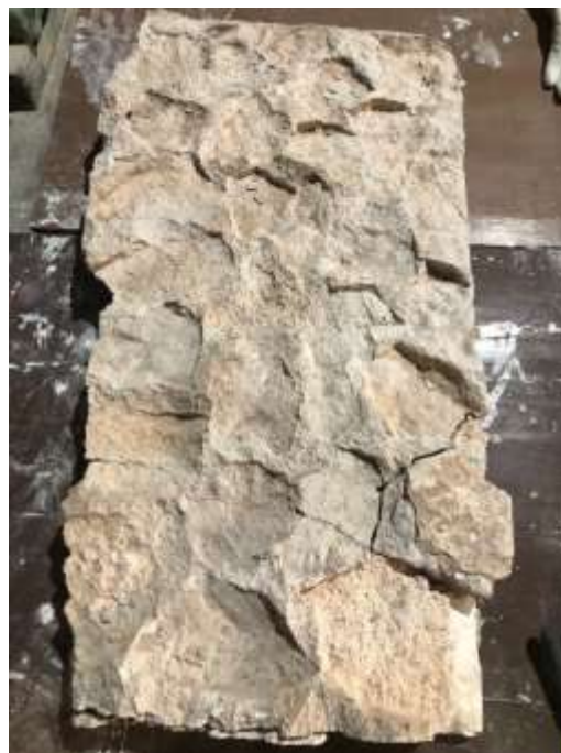
Fig. 30. Secció un cop neta, preparada per ser encofrada.
