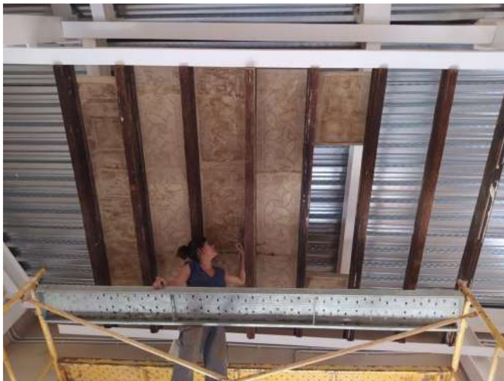
Fig. 54. reintegració cromàtica amb pintura a la calç.
