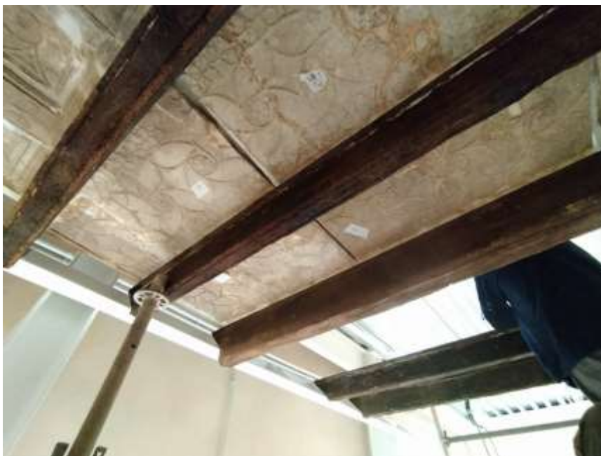
Fig. 51. Seccions col·locades sobre les bigues. Es pot observar l'estructura on es recolza el conjunt.
