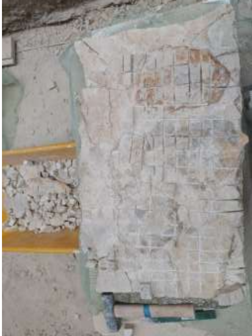
Fig. 27. Llosetes al descobert, posteriorment a l'eliminació de la retícula de morter de guix.
