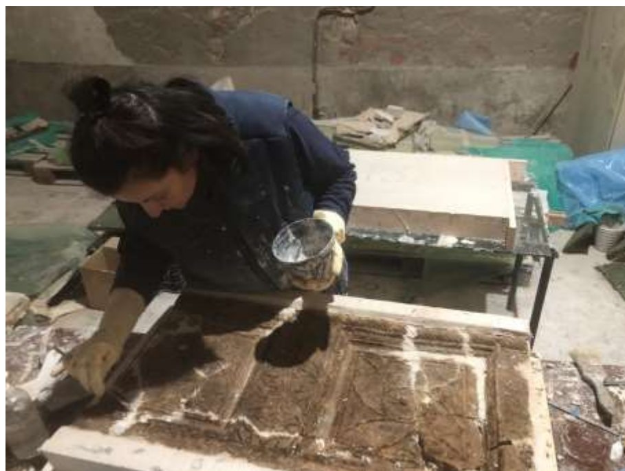
Fig. 37. Estucat d'esquerdes (reintegració de guix).
