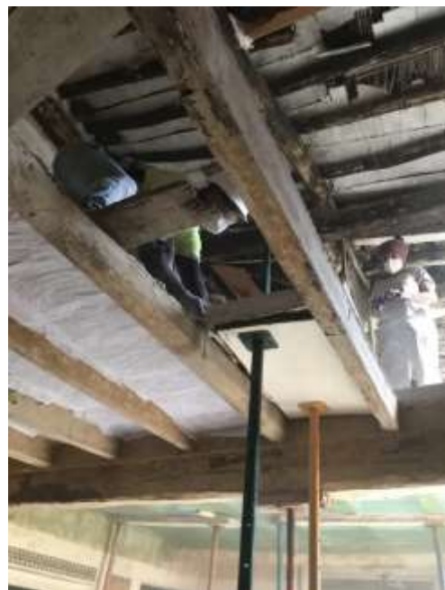
Fig. 16. Exerciç de pressió des de sota per tal de desprender la fracció.
