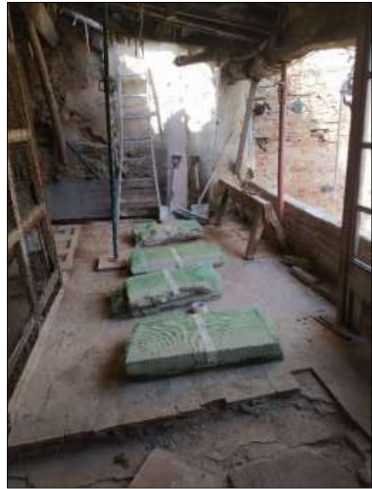
Fig. 20. Peces numerades i embalades, llestes per transportar-les al taller.
