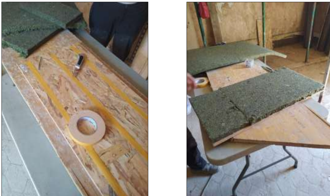
Fig. 10. i Fig. 11. Preparació de les plaques d'OSB amb cinta de doble cara i adhesió del Geopanel®.
