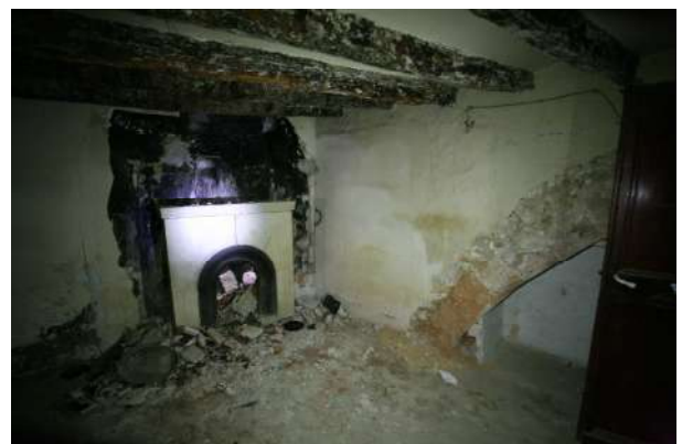
f8. arc medieval interposat als envans posteriors i a l'estructura horitzontal
