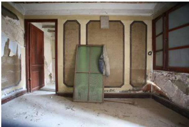
f9. parament vertical divisori, arcs embegut al murs de façana posterior i d'envà.
