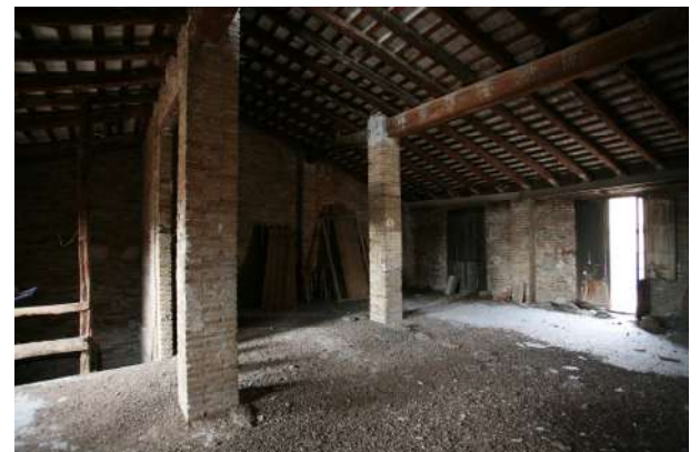
f24. Vista interior del sota-coberta amb l'estructura de pilars i jàsseres originals.
