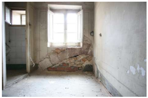
f10. arc medieval embegut a la façana posterior.
