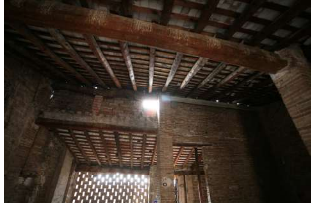
f22. Vista interior del sota-coberta amb l'estructura de pilars i jàsseres originals.
