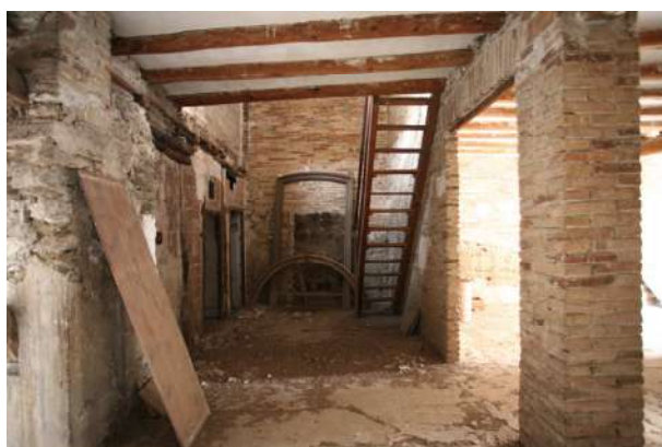
f20. Escala d'accés de la planta segona al sota-coberta.
