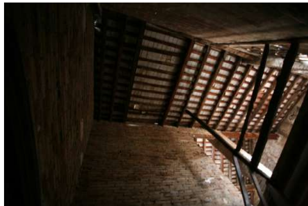
f23. Vista interior del sota-coberta amb l'estructura de pilars i jàsseres originals.
