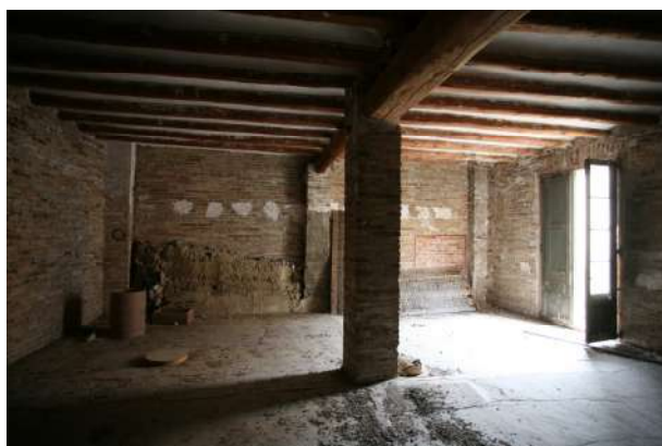
f19. Vista interior planta segona amb el mur de tàpia i els pilars d'obra originals, el sostre és resultat d'una remodelació posterior.
